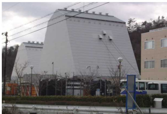
立抗掘削のためのおにぎりのよう防音カバー
